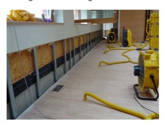
Gemeinsam mit unserer Leitungswasserschaden Versicherung und dem beauftragten Architektenbüro Deubner wurde die weitere Vorgangsweise abgesprochen. Bald stand fest, dass die Wände im gesamten Kindergartenbereich bis ca. 80cm Höhe geöffnet werden müssen (beidseitig) und die nasse Isolierung entfernt wird.
