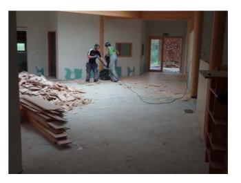
Nach Messung der Feuchtigkeit wurde mit der Wiederherstellung der Wände, Isolierarbeiten, Verfließungsarbeiten,
