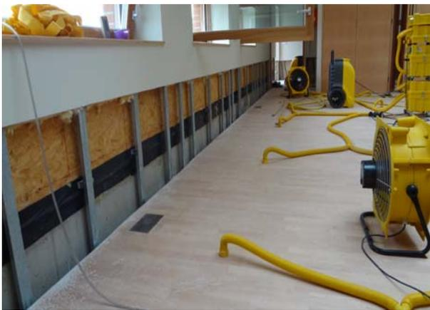
Gemeinsam mit unserer Leitungswasserschaden Versicherung und dem beauftragten Architektenbüro Deubner wurde die weitere Vorgangsweise abgesprochen. Bald stand fest, dass die Wände im gesamten Kindergartenbereich bis ca. 80cm Höhe geöffnet werden müssen (beidseitig) und die nasse Isolierung entfernt wird.
